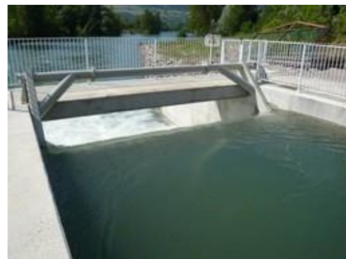
Vue d'une VLH en fonctionnement
