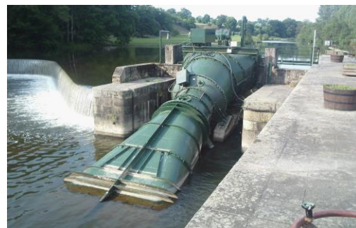
Vue d'un ancien groupe siphon
