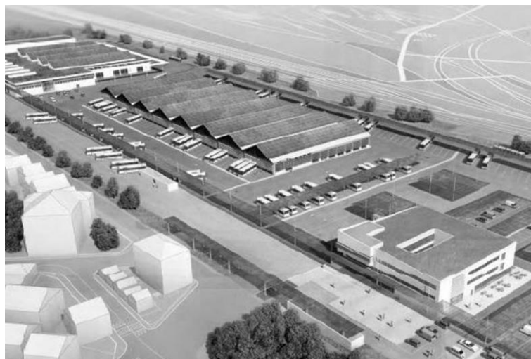
Figure 10 : vue générale du centre d'exploitation
