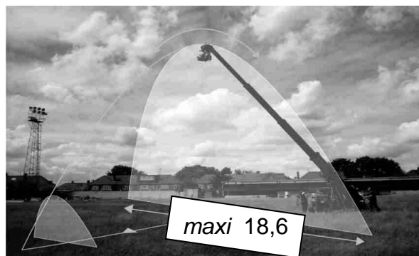
Figure 4 - Visualisation de la zone couverte par le déploiement de la grue
