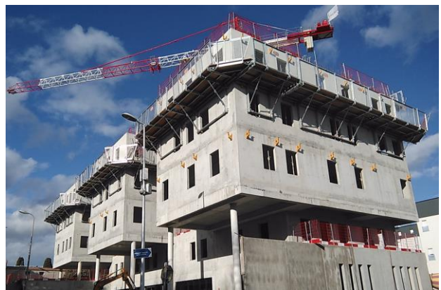
Figure 2 : photo du chantier en cours
