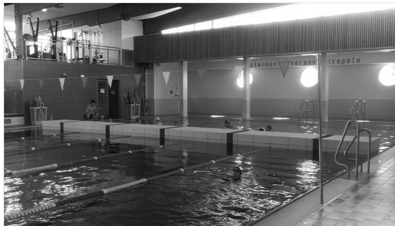
Figure 5 : mur amovible en position dépliée
