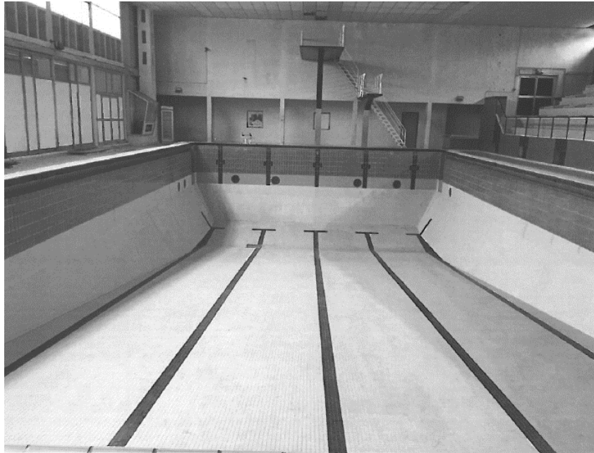
Figure 1 : bassin de 33 m avant rénovation
