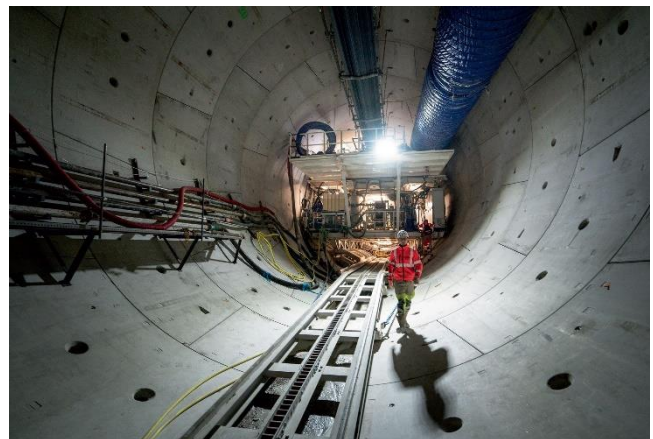
Fig. 7 Les anneaux constituant les parois d'un tunnel
