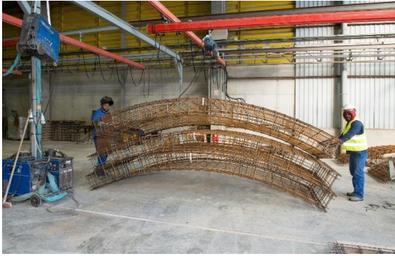
Fig. 8 Structure métallique de voussoirs
