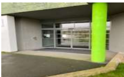
Entrée principale et accès étudiants
