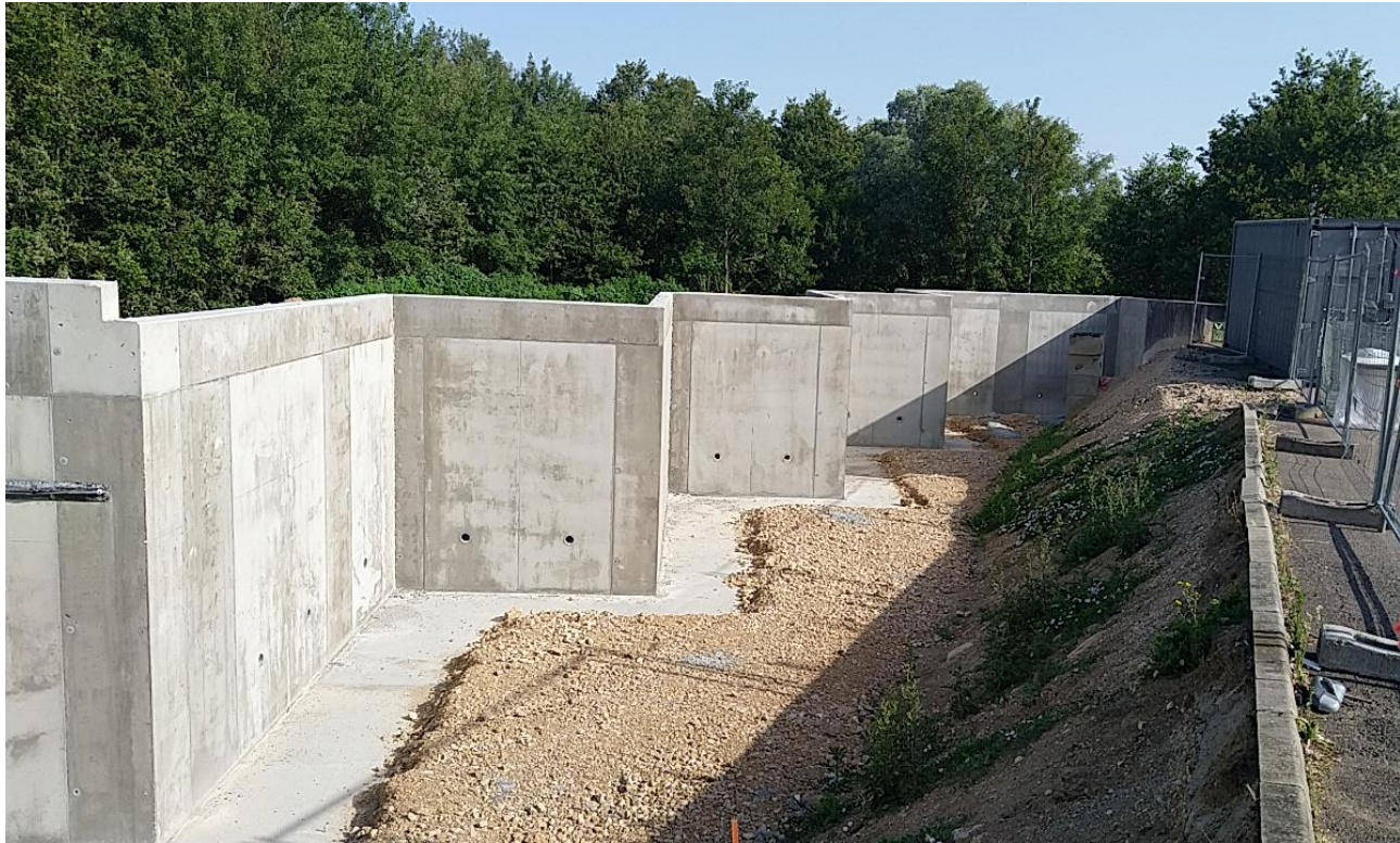
Extension de la déchetterie Cuisery
