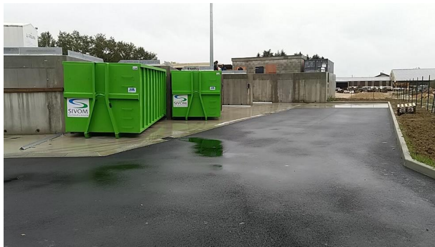
Extension de la déchetterie de Cuisery
