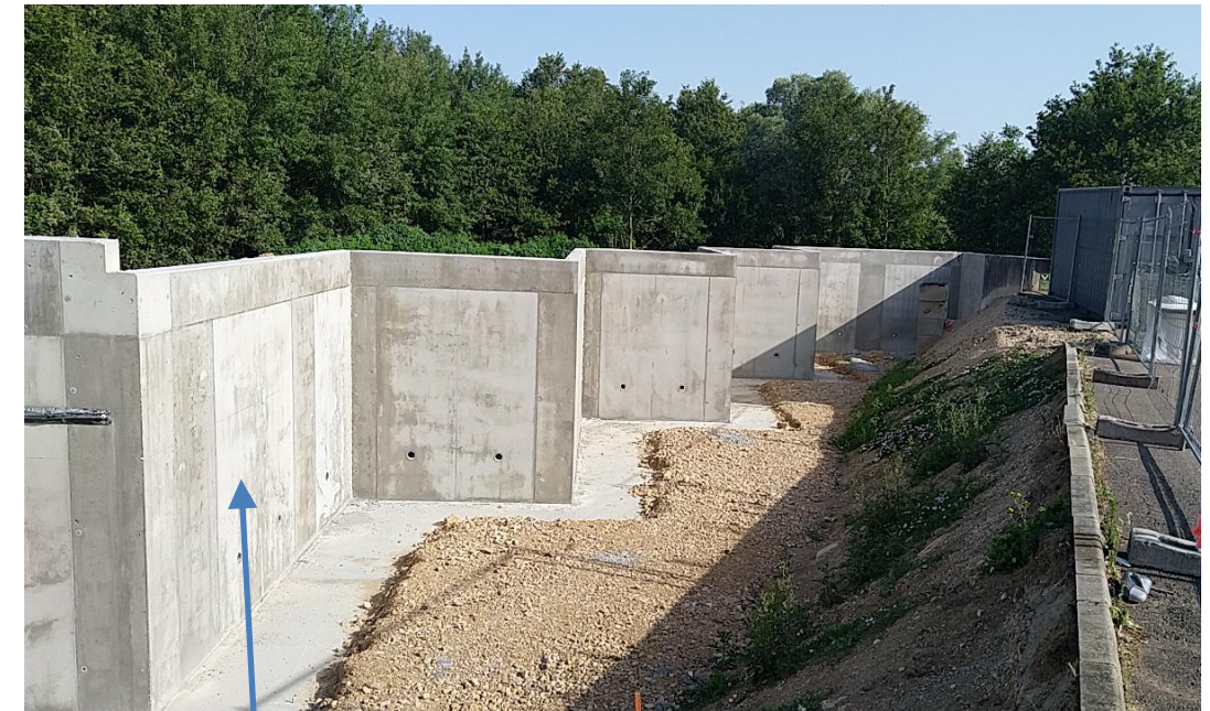
Voiles en béton armé
