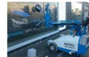
Mini grue de chantier
