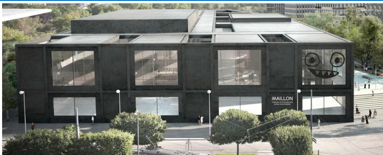
Image 1 : façade sud du Maillon ; Source : LAN (Jallon /Napolitano) Architecte Mandataire
