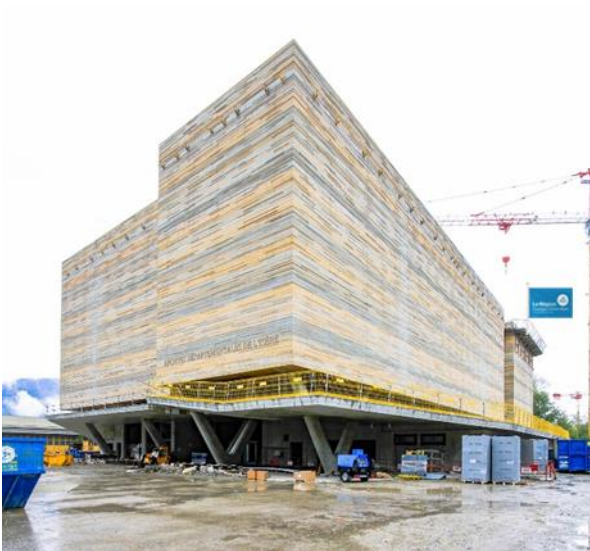
Façade est et Pignon sud :
