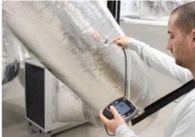
*Figure 15 : mesure de vitesse en conduit*
