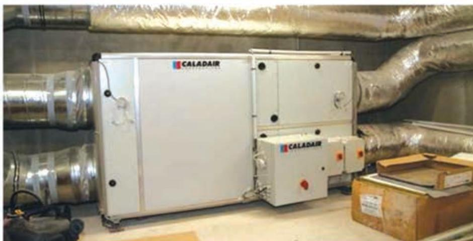
Figure 5 : Centrale de ventilation double flux
