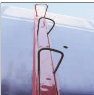
Régle de mise en place des fers en attente
