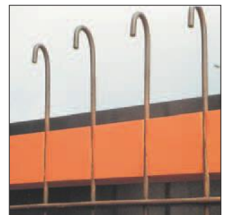
Régle de maintien des armatures
