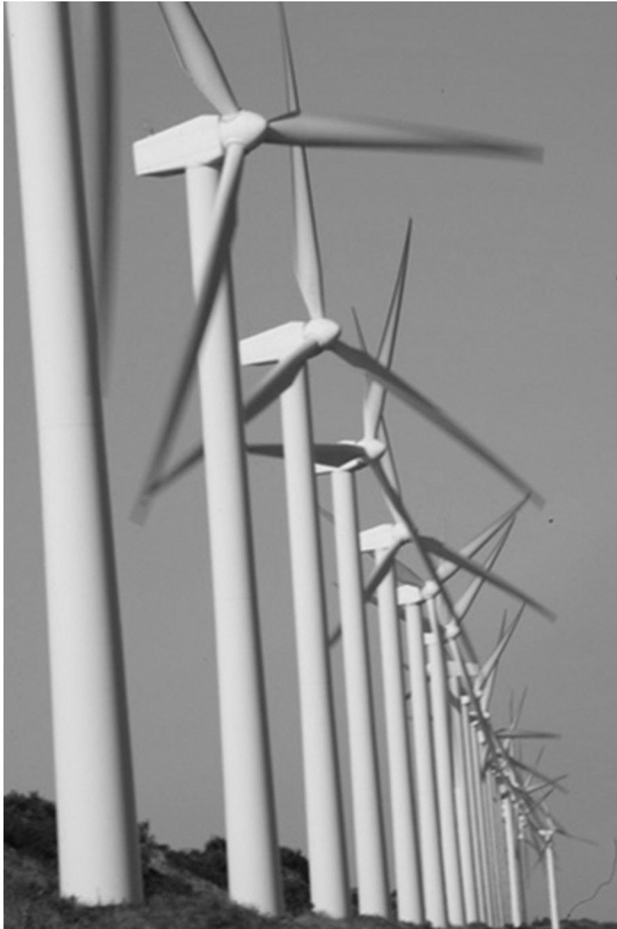
photo 1 : Le parc éolien de Port Saint Louis.
