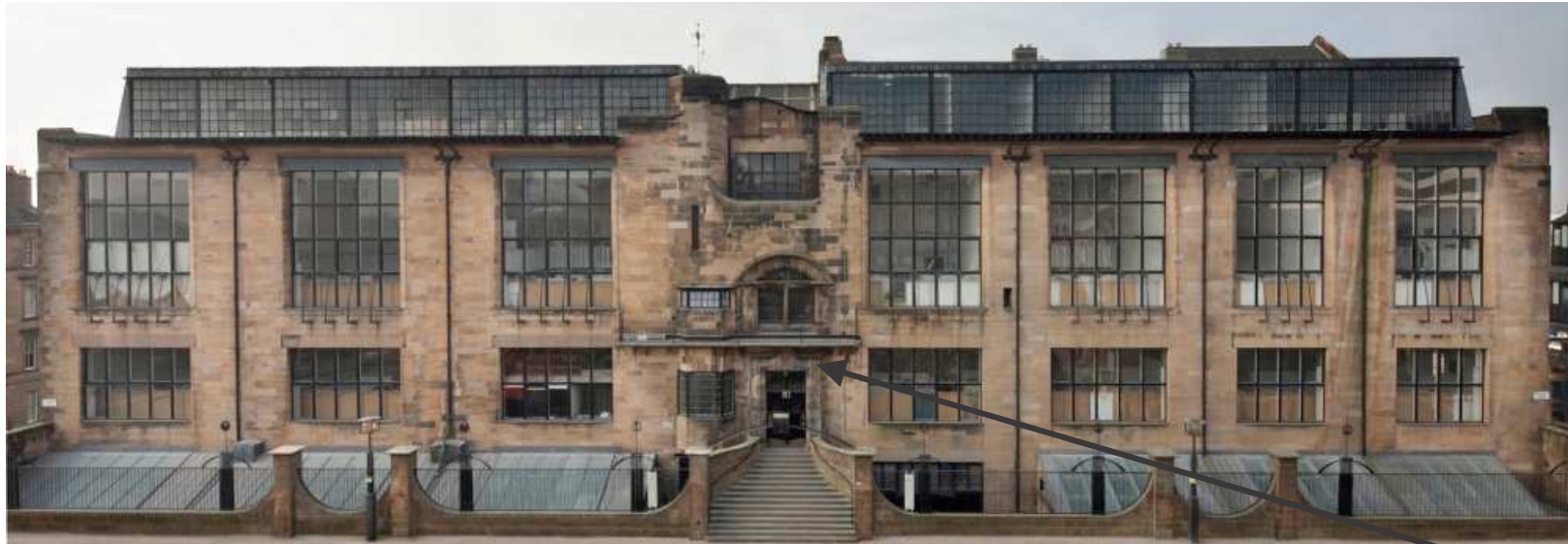
2.1 FAÇADE vue sur l'entrée principale de l'école
