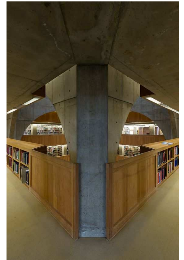
3.4 Vue sur les garde-corps donnant sur le hall d'entrée
