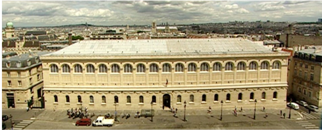
1.1 FAÇADE vue sur l'entrée principale
