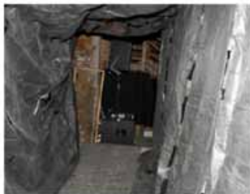
Tunnel de la mine, en cours de construction, lors du festival des Feron Arts 2014.
