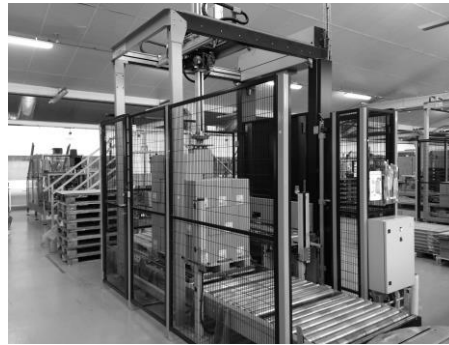
Photo d'une des lignes de palettisation
