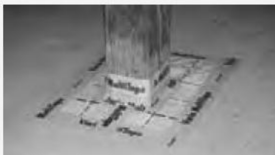
Jonctions entre les planchers, les passages de conduits, les trappes et l'isolation.
