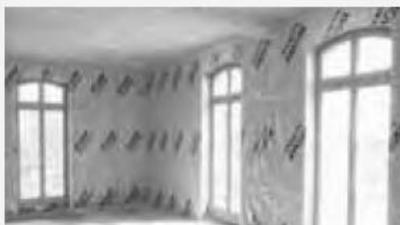
Liaisons entre les menuiseries, la maçonnerie et le doublage.
