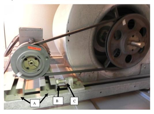
8 - Il faudra inverser 2 phases entre les bornes U2 ET V2 (OU U2 ET W2, OU V2 ET W2)
