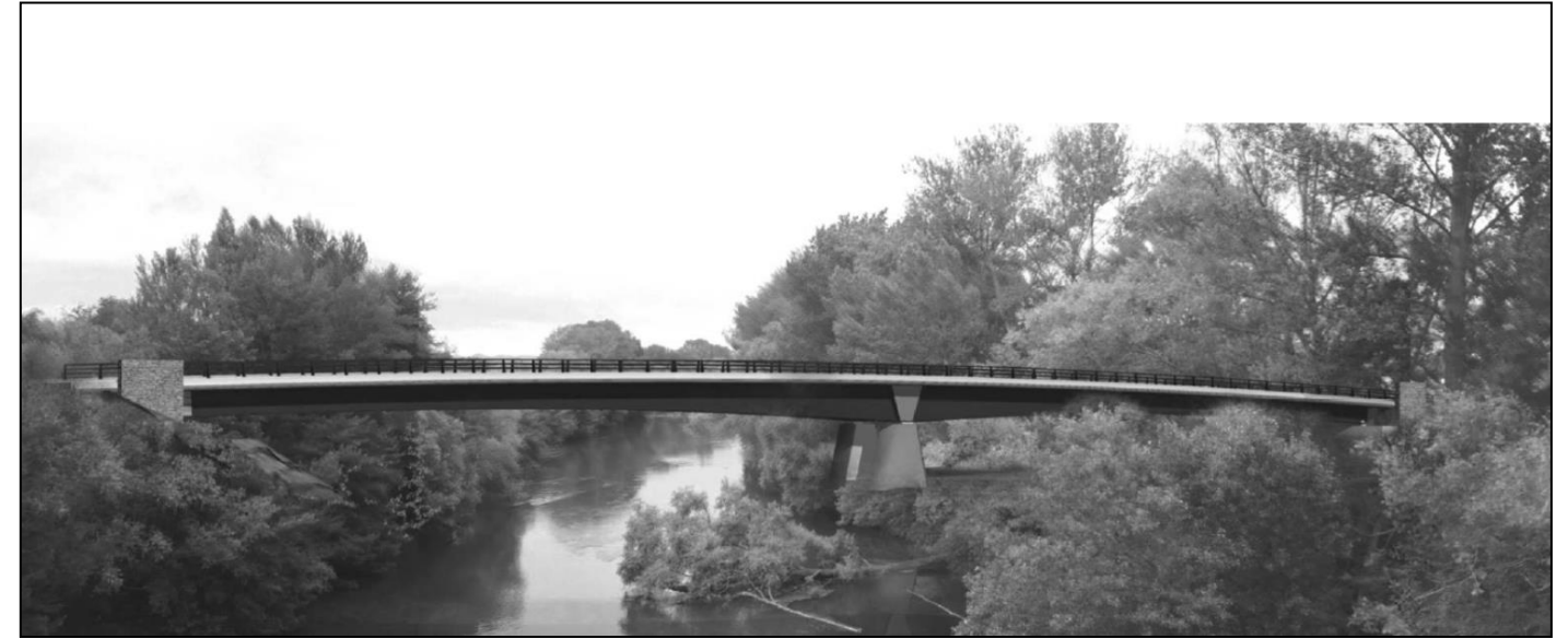
Insertion paysagère du nouveau pont sur l'Aude
