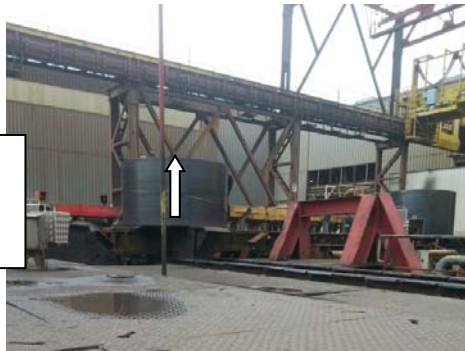
Étape 3 : Sortie de la poutre du convoyeur de récupération
