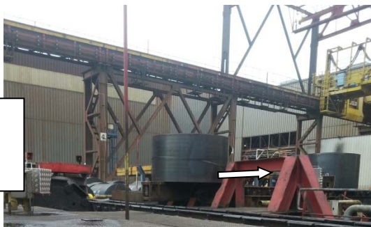
Étape 5 : Rentrée de la poutre du convoyeur de récupération
