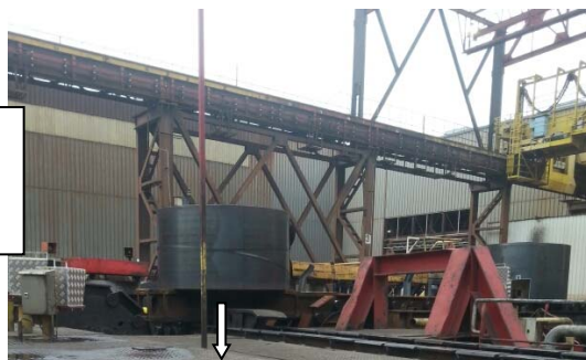
Étape 5 : Rentrée de la poutre du convoyeur de récupération
