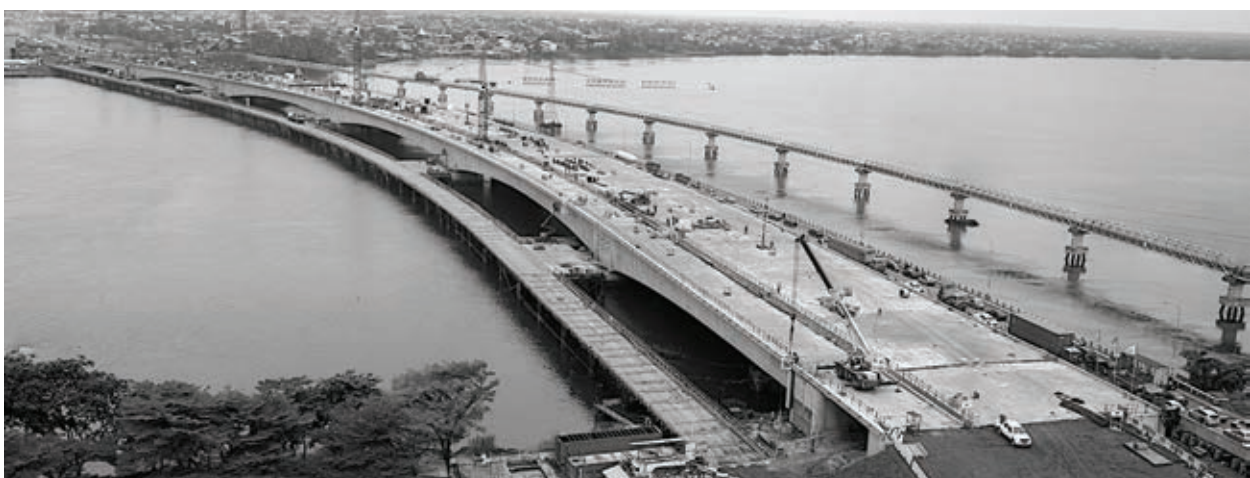
Figure 5 : vue d'ensemble du chantier, à gauche l'estacade, au milieu le nouveau pont en partie réalisé, à droite, l'ancien pont
