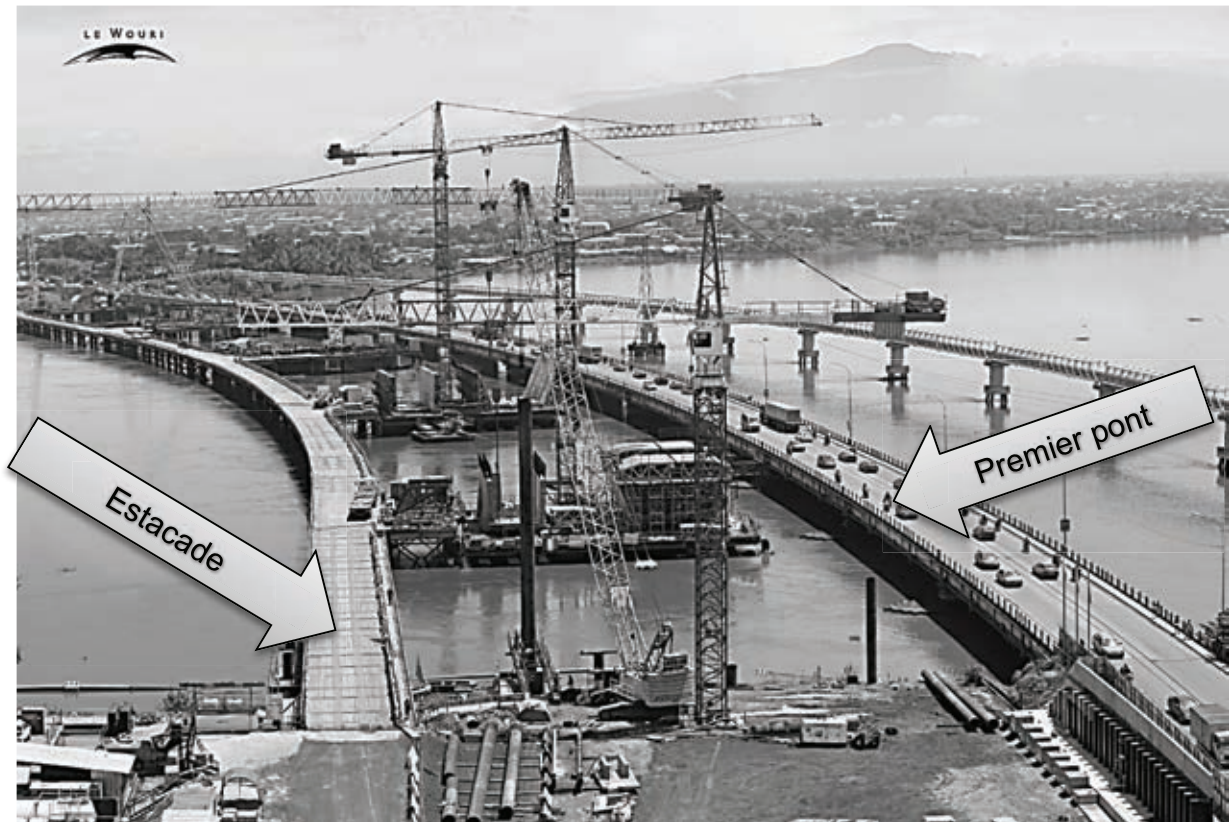
Figure 4 : vue d'ensemble du chantier avant la construction des tabliers.
