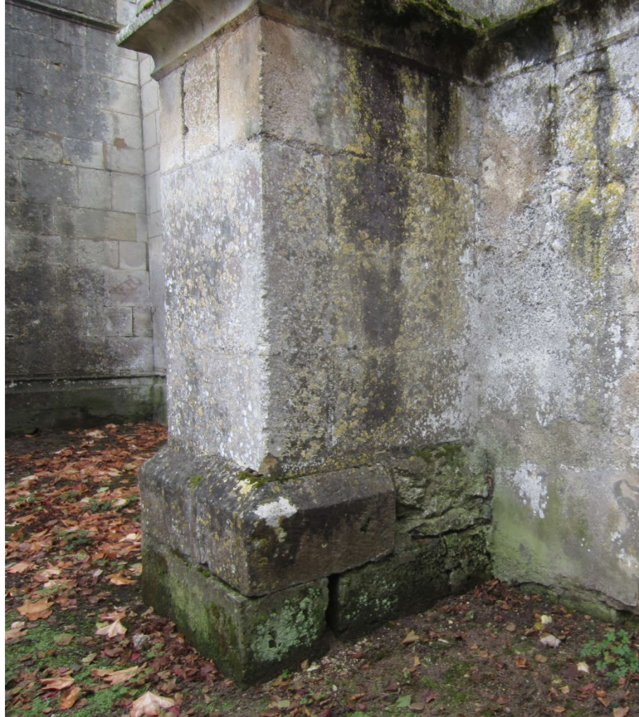
Contrefort façade nord
