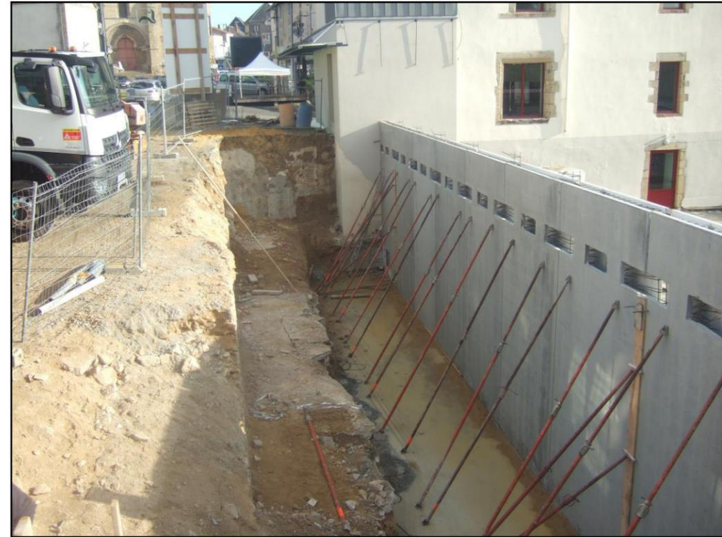
Coulage du Mur n°2 (photo chantier) :
