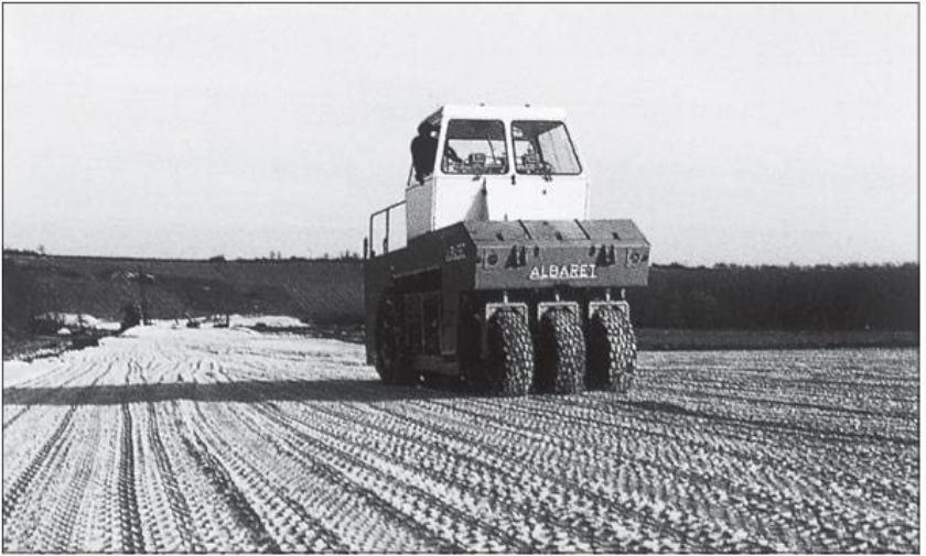
Un compacteur lourd à pneus de la classe P3 (charge par roue > 60KN) particulièrement efficace et polyvalent...
