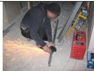
Matériel : blanchement du matériel électroportatif dans le tableau de chantier. Utilisation du perforateur électrique, baladeuse, meuleuse d'angle, visseuse. L'ensemble est alimenté sur le secteur.
