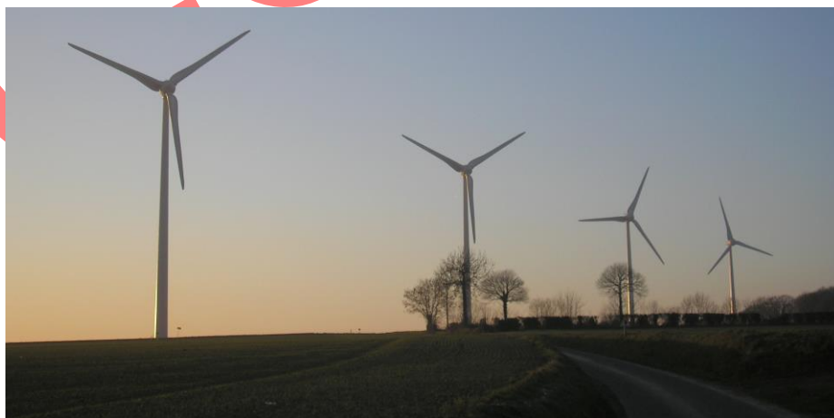
Projet de parc éolien WindPicardie
