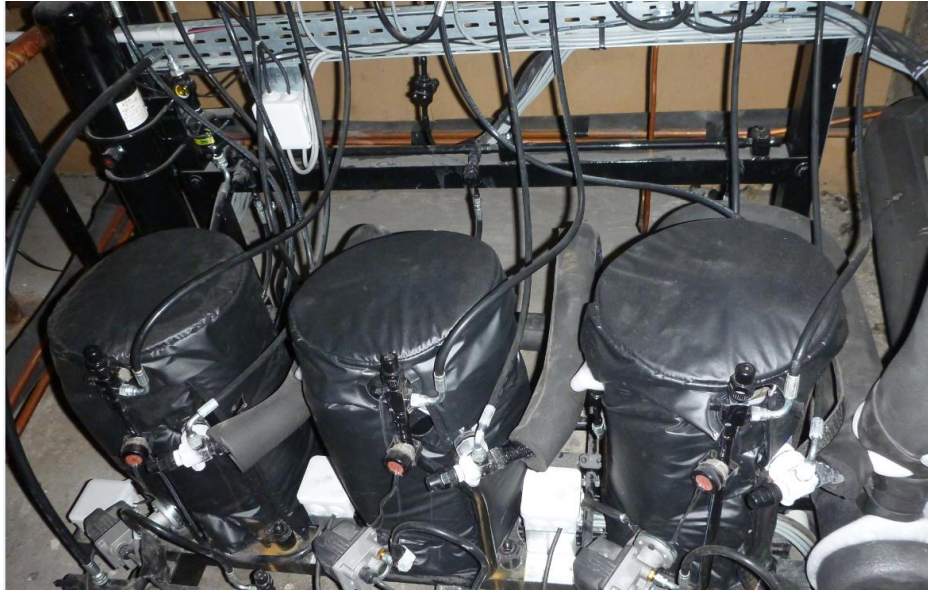
FIGURE 22. PRESENCE SYSTEMATIQUES DE FLEXIBLE
