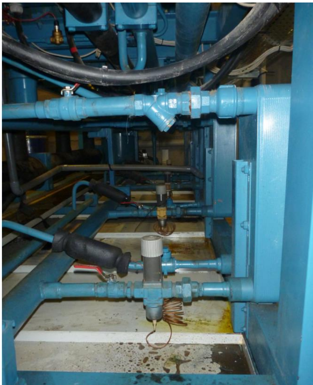
FIGURE 19. PRESENCE D'HUILE SUR LE SOL
