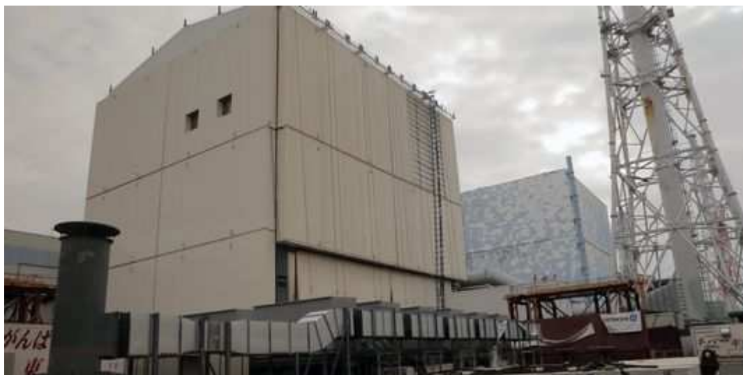
Vue des réacteurs numéro 1 et 2 de la centrale de Fukushima, en décembre 2012. | AP/Itsuo Inouye
