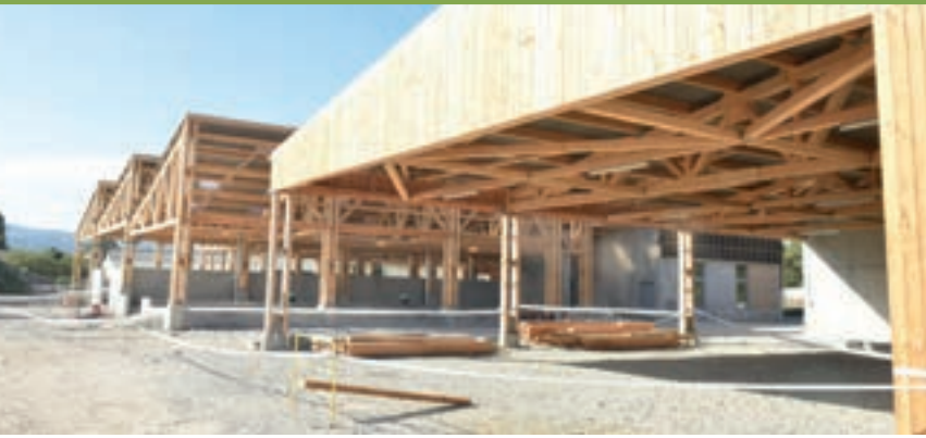
▲ Un lycée construction bois dans la Drôme
