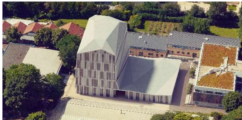
Nouveau bâtiment de l'ESTP
