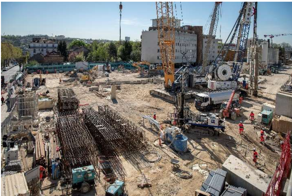
Chantier de la Gare d'Arcueil-Cachan Photo Société du Grand Paris
