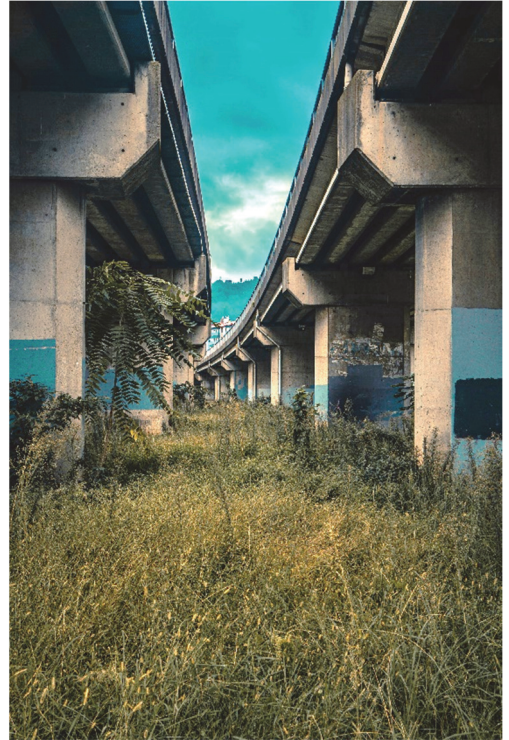
2. Friche sous un pont d'autoroute
