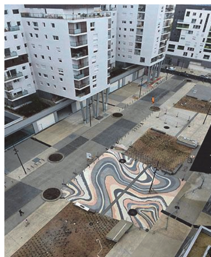
Vue aérienne, place du Général de Gaulle, Ivry-sur-Seine, 2015.
