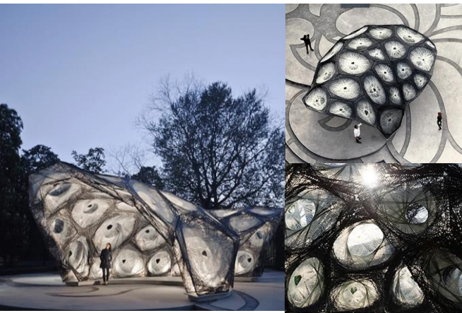
2015. Université de Stuttgart. Pavillon Biomimétique constitué d'une structure polymère renforcée de fibres naturelles, né de la collaboration entre biologistes, ingénieurs. et architectes.
