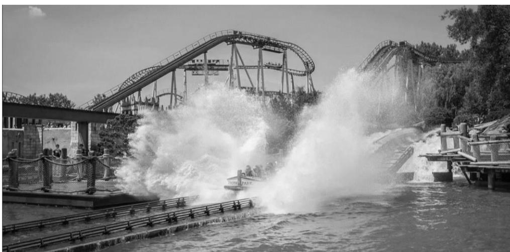
Le FJORD EXPLORER associe des parties nautiques et une partie à sensations fortes qui culmine à 28 m de haut, avec une chute finale de 18 m, une vitesse maximale de  $79 \text{ km}\cdot\text{h}^{-1}$ , pour un parcours de 600 m (**DT3 – Zones du FJORD EXPLORER**).
