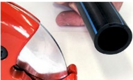
1 Couper le tube d'équerre avec une cisaille coupe-tube pour le PE.
