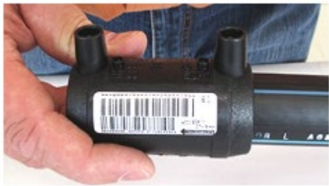
2 Insérer le tube dans le manchon et venir en butée
