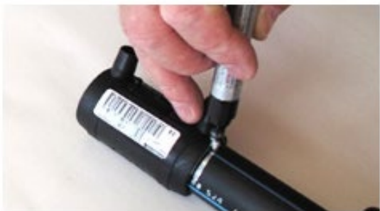
3 Repérer l'emboîtement avec le marqueur argent spécial PE
