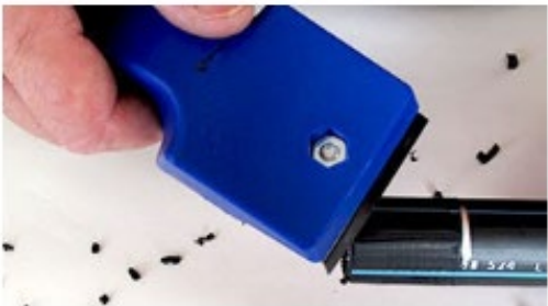
4 Gratter toute la surface jusqu'au trait. Dégraisser toute la surface grattée avec une lingette dégraissante
