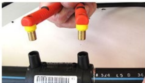
7 Insérer les cosses de soudure. Elles peuvent être branchées indifféremment.
