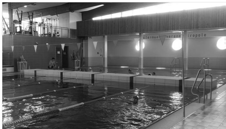
Figure 5 : mur amovible en position dépliée
