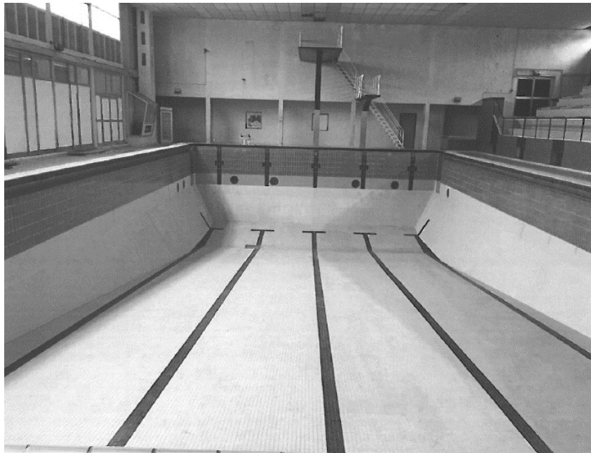
Figure 1 : bassin de 33 m avant rénovation
