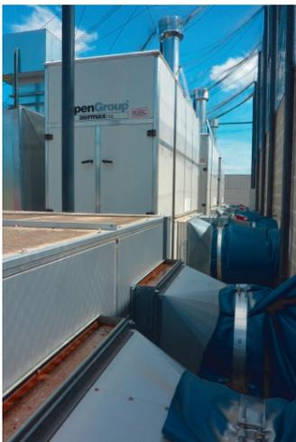
Trois générateurs d'air chaud placés à l'extérieur injectent de l'air neuf dans le volume du dôme afin de maintenir une pression constante de 300 Pa selon les conditions météorologiques.
