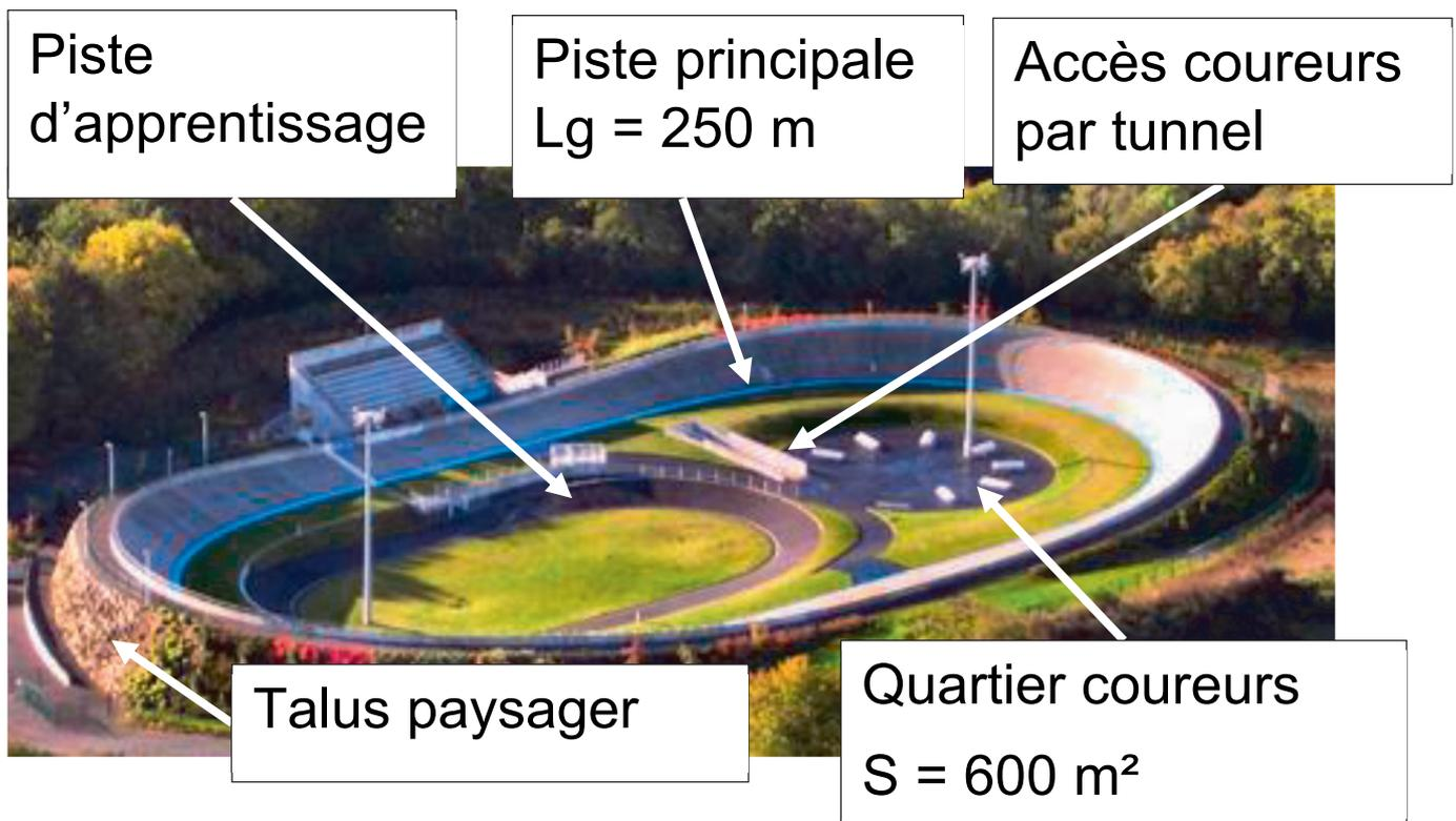
Dès le début du projet, le client envisageait une piste en béton, notamment pour sa capacité à résister aux intempéries. Il existe des pistes en béton sur remblai ou en béton sur ossature, dont les principes constructifs sont présentés dans le DT1.
