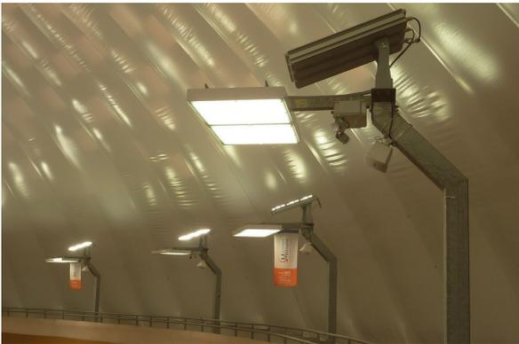
Le niveau d'éclairage vertical requis pour un classement en catégorie 2 du vélodrome est 1000 lux minimum avec un coefficient d'uniformité de 0,7 ( $U_0$ ).
