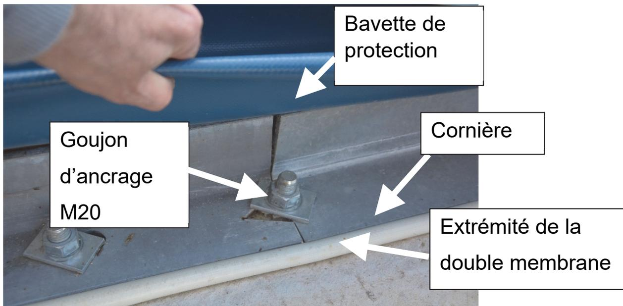
Le bureau d'études structure a déterminé les composantes de la force maximale  $\vec{F}$  appliquée sur un goujon d'ancrage au point A (DRS3) :
