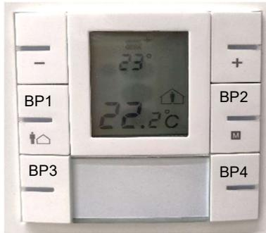
S3-BP1 : ouverture / fermeture du volet roulant V1 de la chambre
