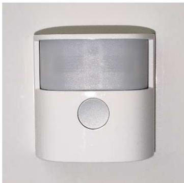
S4-DdM1 : allumage automatique du point lumineux L3 du couloir par détection de présence avec minuterie de 20s et avec préavis d'extinction de 15s.
