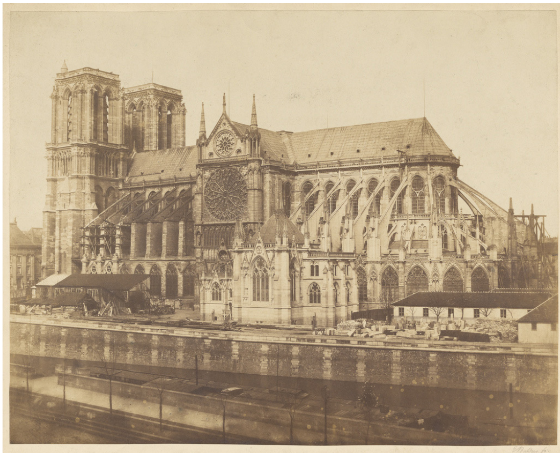
Fig. 3. La cathédrale en chantier, par le photographe Édouard Baldus : la sacristie est déjà construite, non la flèche.
