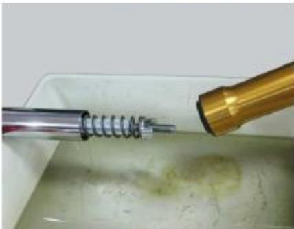
Maintenant il est possible de remplacer les éléments d'étanchéité.
