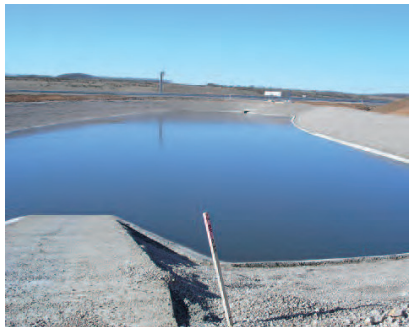
Réalisation de bassins de rétention et d'infiltration sur l'autoroute A75.
