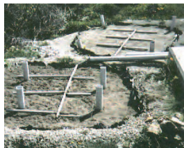
Amélioration de l'assainissement agricole : ici fosse toutes eaux et filtre à sable pour le traitement des eaux blanches issues des salles de traite.
