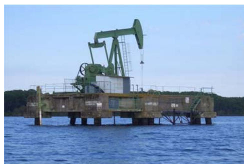
Station de pompage sur l'étang de Biscarosse
