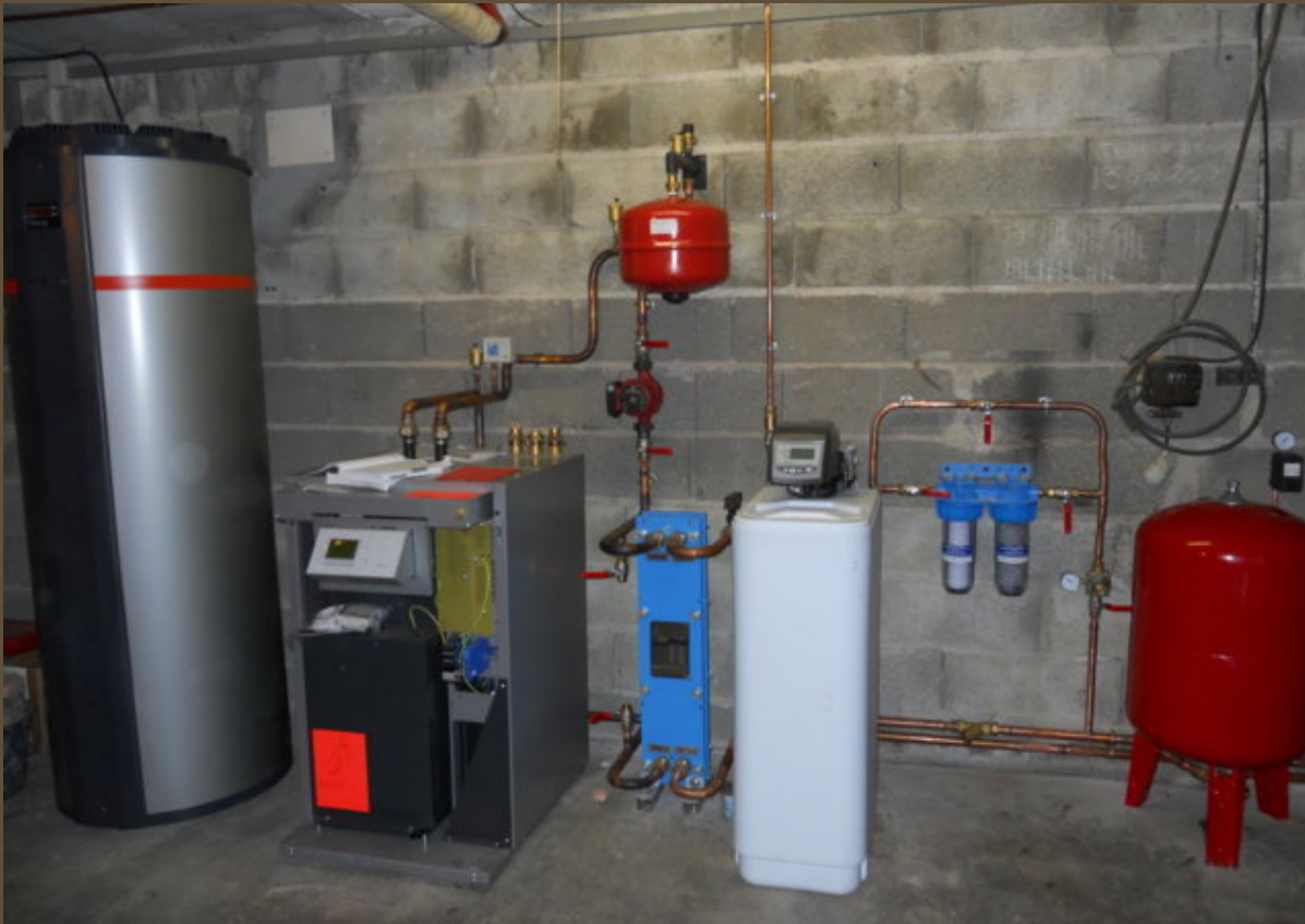
Photo d'installation d'une pompe à chaleur
