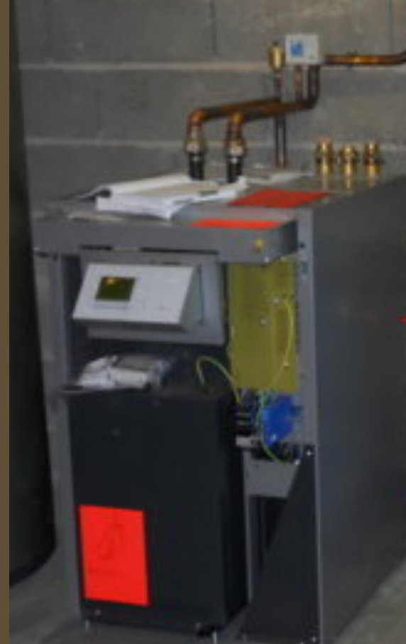
Raccordement électrique de la pompe à chaleur obligatoire
