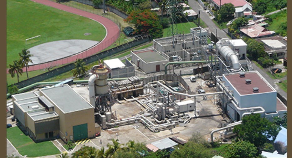
Centrale géothermique de Bouillante en Guadeloupe
