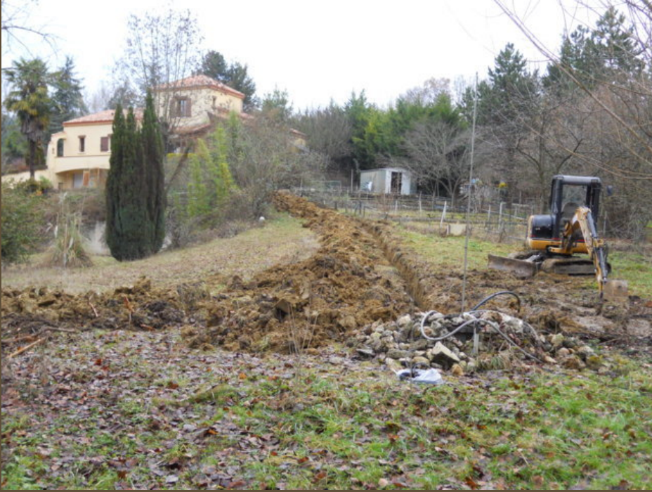
Travaux de terrassement lors d'une installation en géothermie
