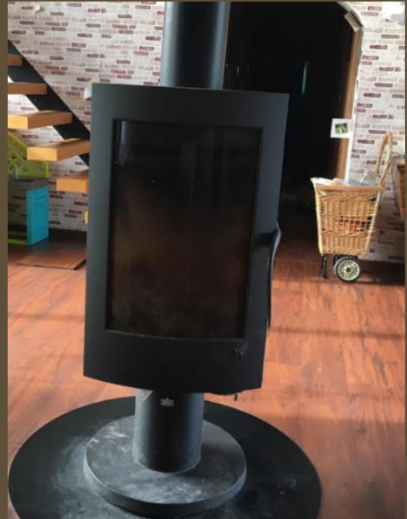
Photo d'installation d'un poêle à bois
