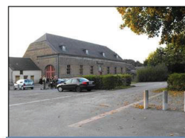
3 -La maison du Parc naturel de l'Avesnois à Maroilles
