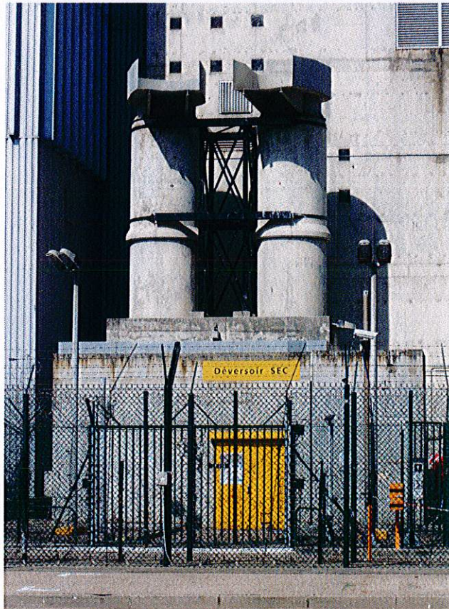
Déversoir SEC et ses cheminées
