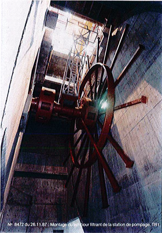
Montage tambour filtrant à Penly
