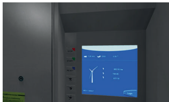
11 La centrale thermique : automate au pied du mât permettant l'arrêt de l'éolienne en vue de sa maintenance
