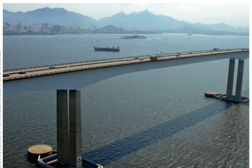
4 Un pont à poutres : le pont Presidente Costa e Silva entre Rio de Janeiro et Niterói (Brésil)
